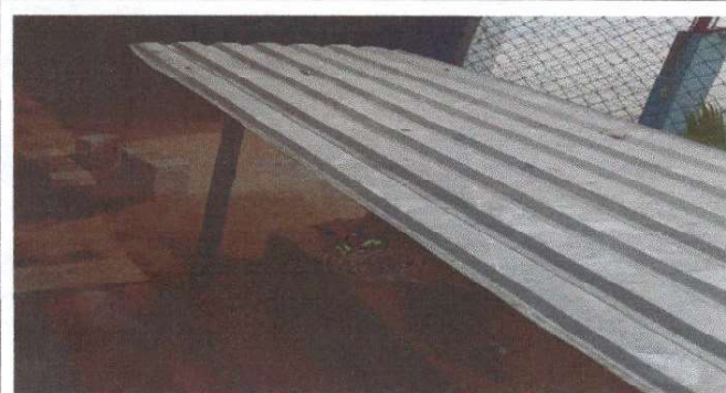
Foto 3: Sustitución de lamina troquelada aluzinc calibre 26
