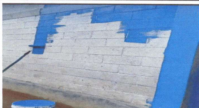
Foto1: Pintura de exteriores.
