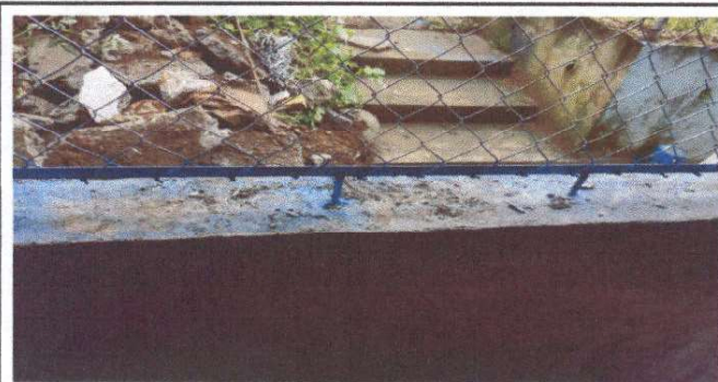
Foto 5: Mantenimiento a estructura de soporte de metal.
