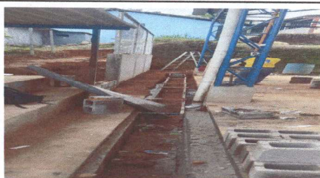
Foto 2: Canales y bajadas de agua.
