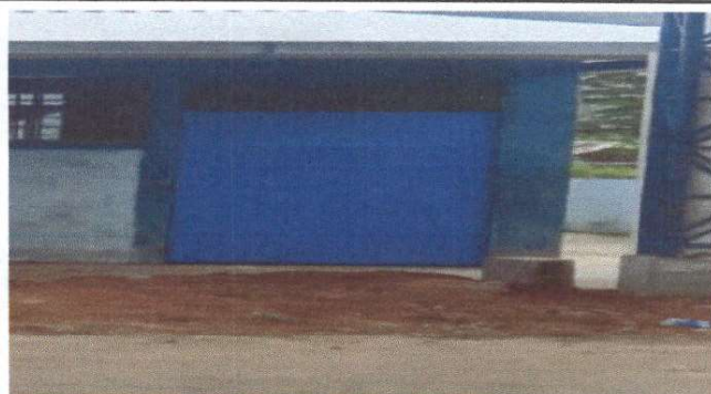
Foto 4: Mantenimiento a puertas de metal.
