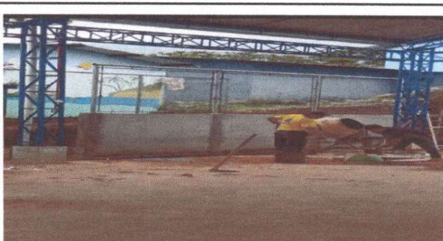
Foto 6: Reparación de muro perimetral.
